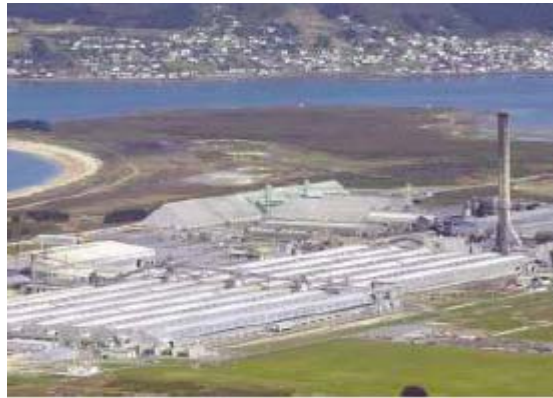
Rio Tinto Group – Comalco металлургическое производство алюминия. Плавный пуск для вентиляторов и шаровых мельниц.
