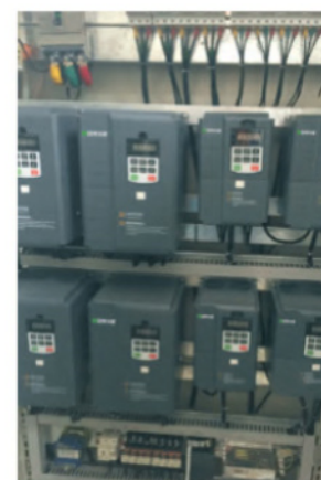
Система очистки воды
