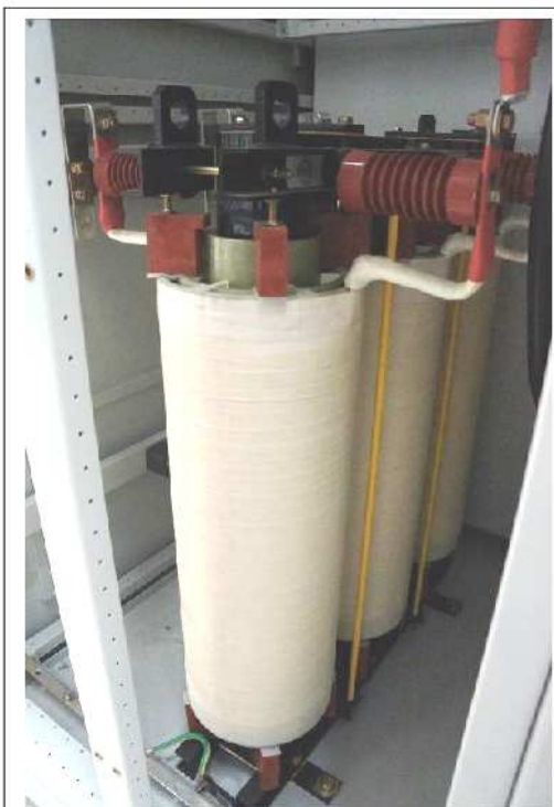
Рисунок 1.12 – Реактор для синхронизированного перевода
