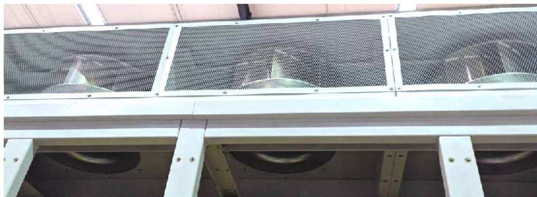
Рисунок 1.13 – Охлаждающие вентиляторы в кожухе (вид снизу)
